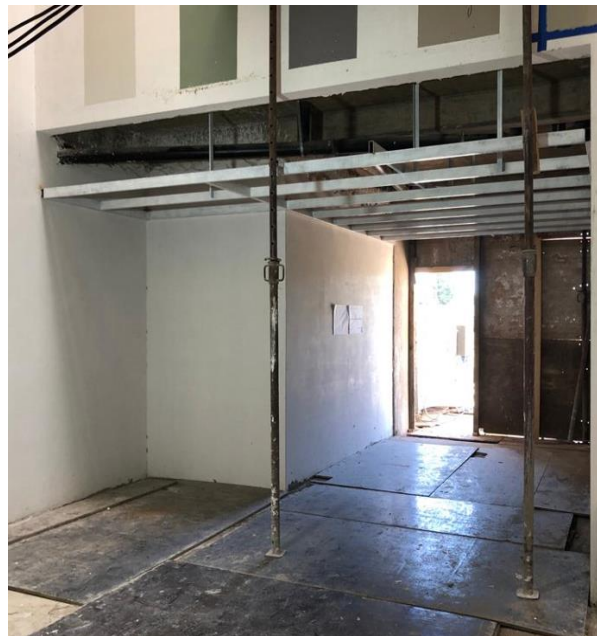
Colocación de estructura en ingreso
