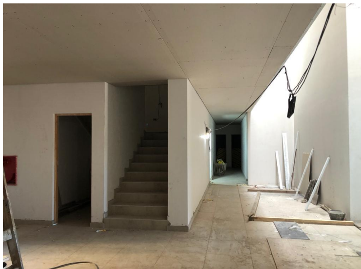
Colocación placas de roca de yeso en planta baja.
