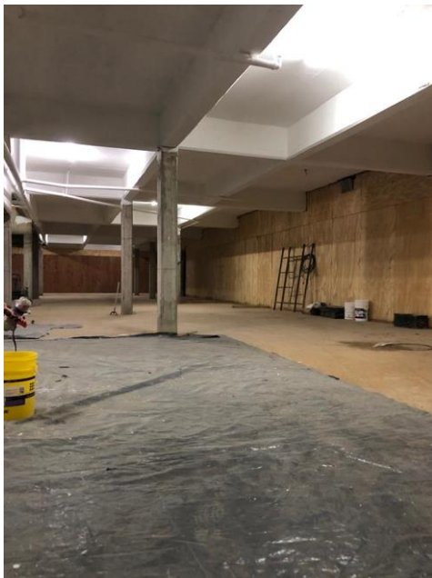
Pintura en subsuelo
